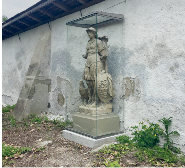
Neue Erhaltungsstrategien für klimaresiliente Baudenkmäler. Jegenstorf Schlosspark, Begrenzungsmauer mit Feuchtigkeitsschäden und Schutzkasten für Statue. (Bild: Stefan Wülfert)
